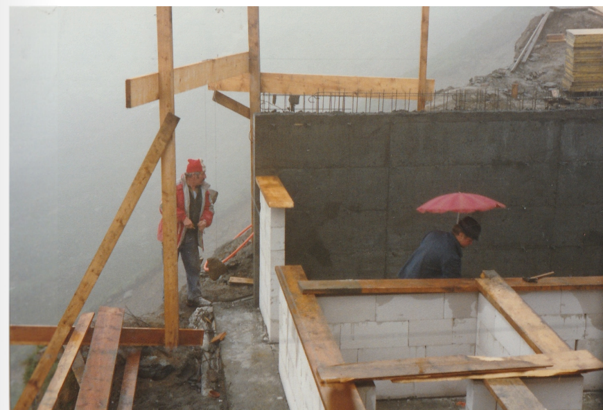
Seite 21 und 22: Sanierung und Anbau/Heli- Landeplatz Juni bis Mitte September 1990
